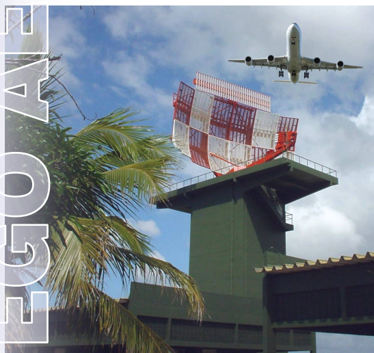
Sítio do radar de controle em rota instalado na cidade de Salvador, BA.
